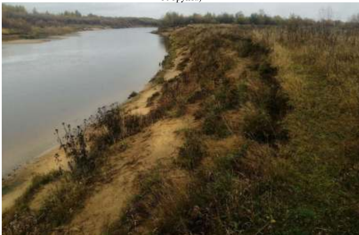
Рисунок 8.7 Внешние проявления оползневых процессов (плоскости срыва блоков песчаного грунта)
